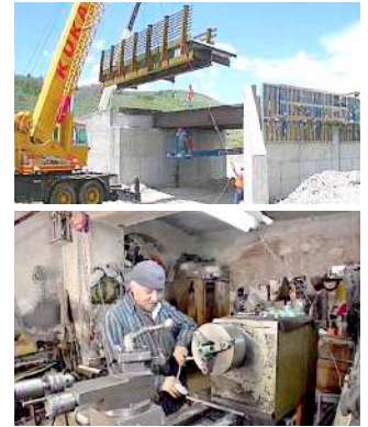
Tanto en la construcción de puentes con materiales prefabricados y la tornería se aplican siempre la precisión y exactitud.
