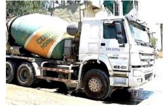
Mediciones con instrumentos topográficos y camión mezclador de cemento con unidades de medida norteamericanas.
