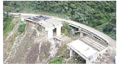
Construcción del puente ubicado en el sillar, Cochabamba.
