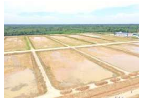
Construcción del complejo piscícola en Chimoré
