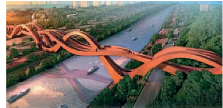
Puente Ondulado en China
