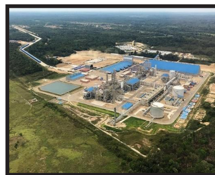
Planta Amoniaco - Urea, la primera planta petroquímica inicia operaciones y Bolivia ingresa a la era de la industrialización.
