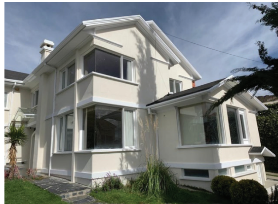
Imagen 18: ARQUITECTURA MODERNA DE VIVIENDA
