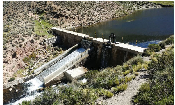
Pequeña Central Hidroeléctrica El Condor
